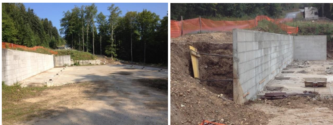
Démarrage du chantier après travaux de démolition [septembre 2012] (photos François L. Althaus)
