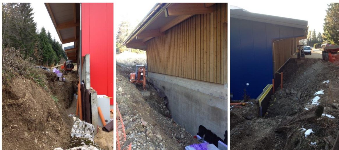
Isolation et drainage du mur existant [novembre 2013] (photos François L. Althaus)
