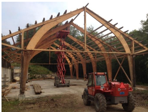
Déconstruction du hangar existant [août 2012] (photo François L. Althaus)
