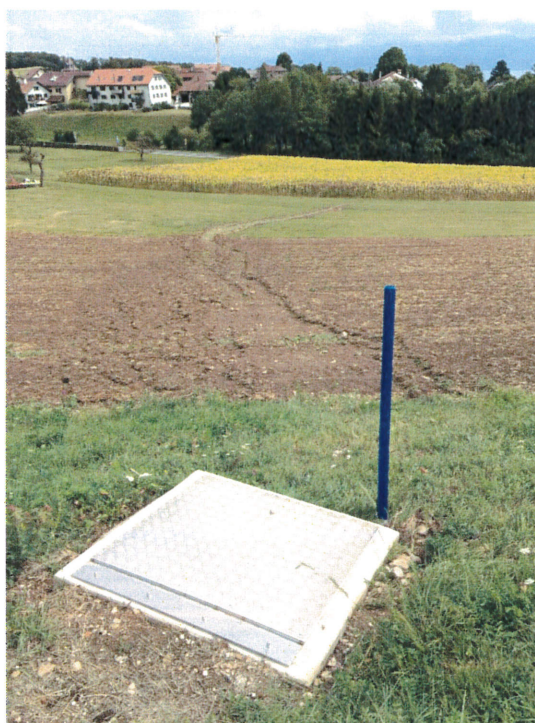
Chambre de décharge n°7
