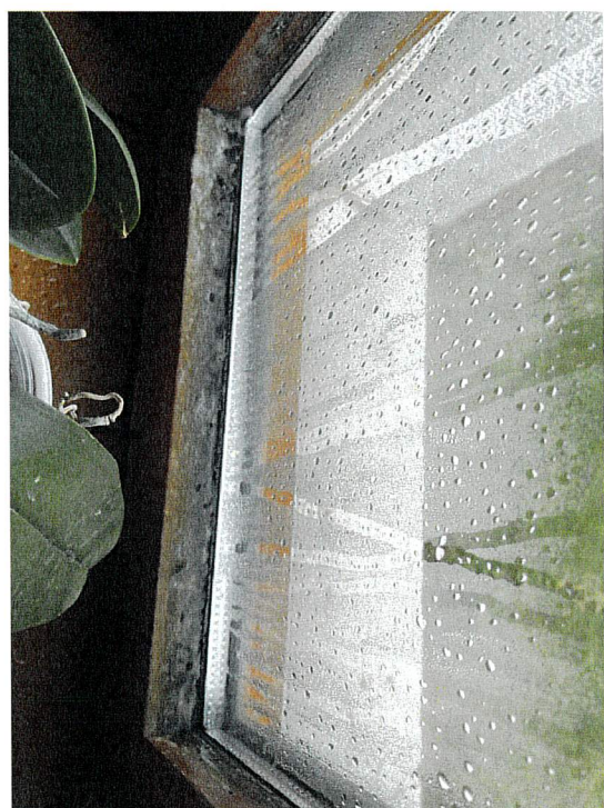
Condensation sur les fenêtre
