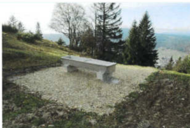
Fig. 4 : Exemple de bassin de 600 l. avec renforcement du sol
