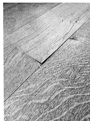
Figure 1 - Lamelle endommagée
