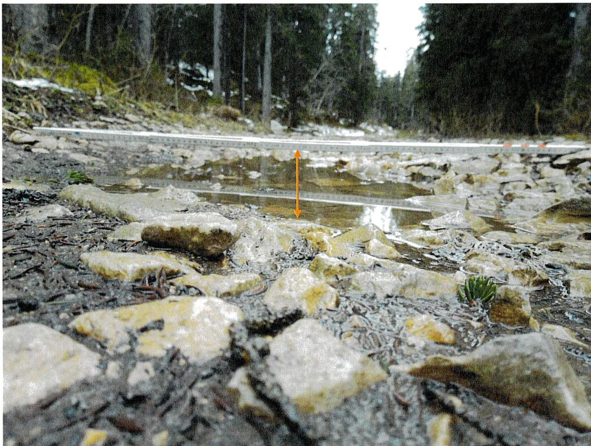
Le double-mètre représente la hauteur initiale de la couche d'usure. La flèche orange représente l'érosion de la couche d'usure avec le temps.
