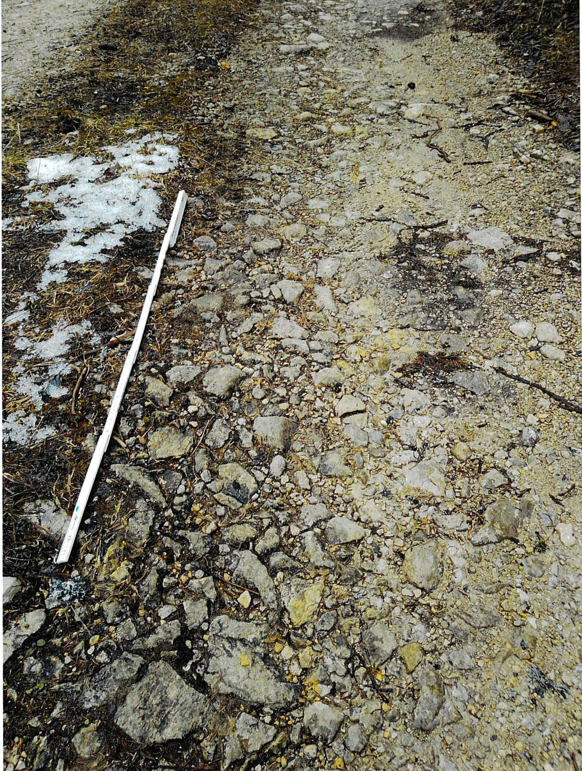
Coffre du chemin visible. Il n'y a plus de couche d'usure. Double mètre = 1 mètre
