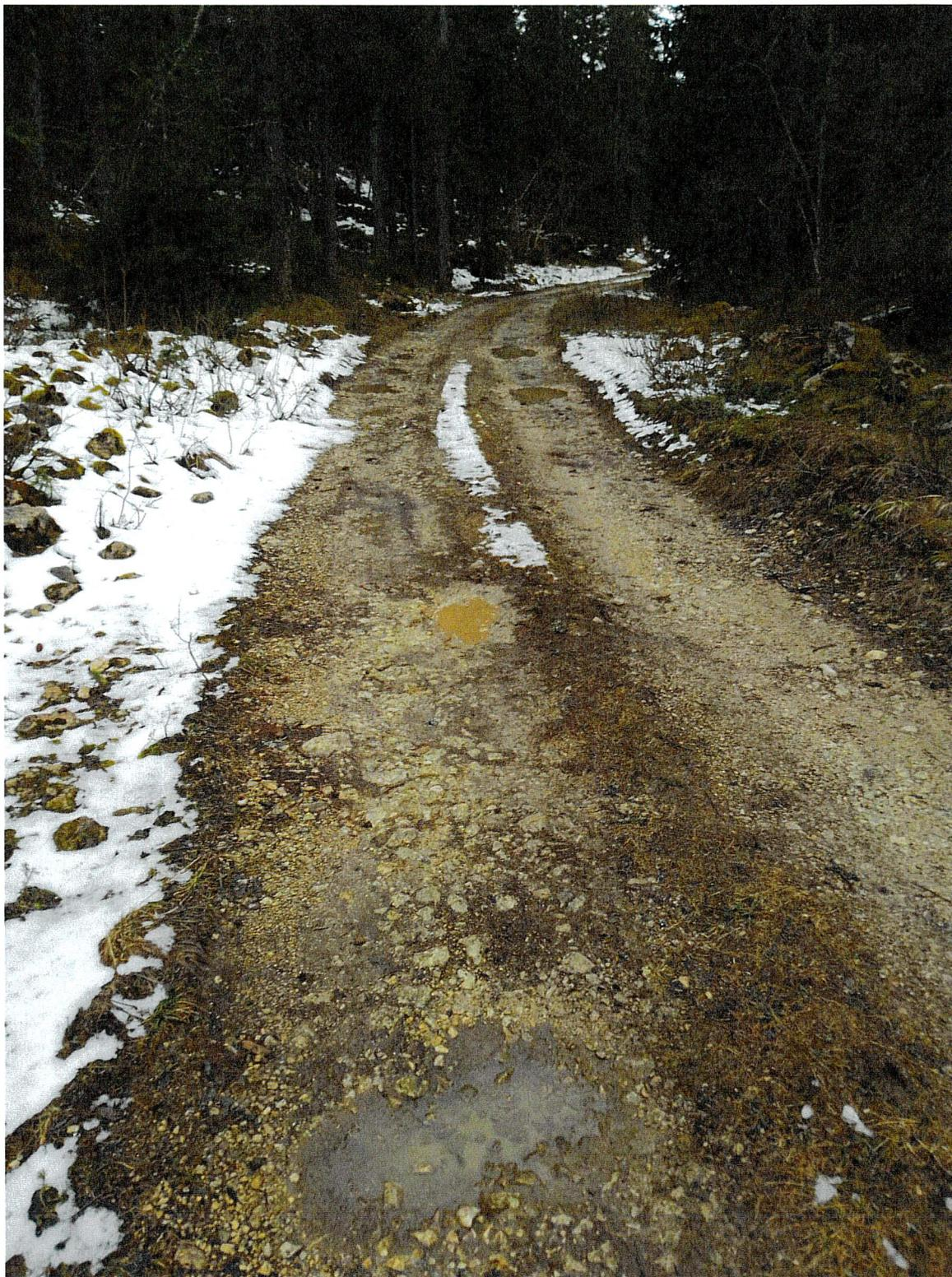
Formation de flaques d'eau à cause des nids de poule. L'eau va infiltrer le coffre et causer plus de dommages.
