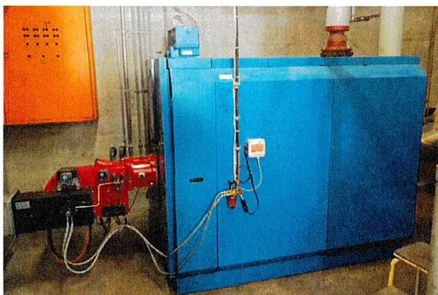
La chaudière à mazout, d'une capacité de 660 kW, est destinée à assurer l'appoint et la redondance de la chaudière à bois. Elle assure le 100% des besoins depuis 2020. En bon état et répondant aux normes, elle ne nécessite pas de travaux à court terme.
